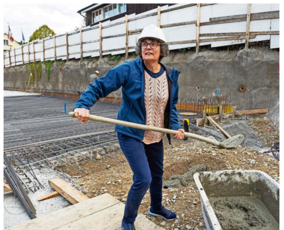
Zells Gemeindepräsidentin Regula Ehrismann legt bei der Grundsteinlegung selber Hand an.
